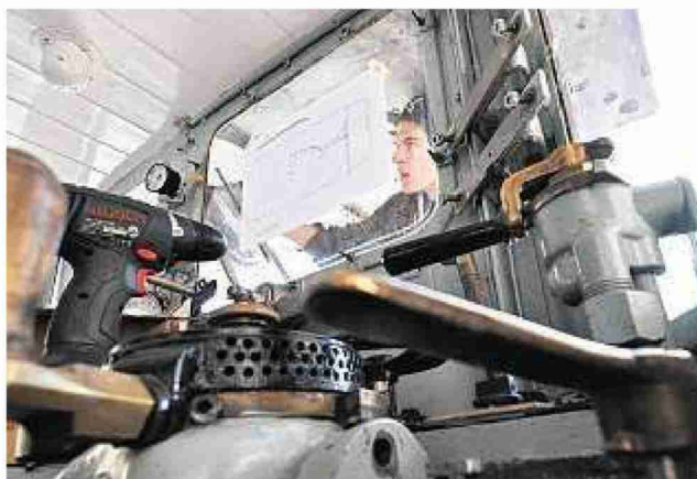
... bereitet Milan Stijovic die Verkabelung für den Simulatoreinbau vor.
