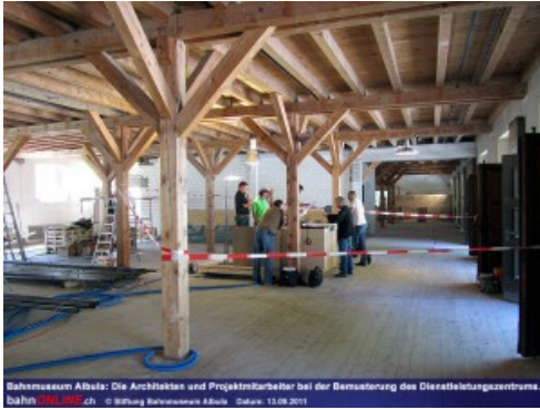
Bahnmuseum Albula: Die Architekten und Projektmitarbeiter bei der Bemessung des Dienstleistungszentrums. bahnONLINE.ch © Stiftung Bahnmuseum Albula - Bildart: 13.08.2011
